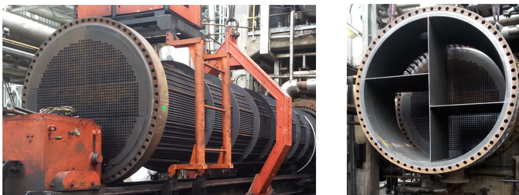
Obr. 1 Přírubové spoje mezichladiče.
